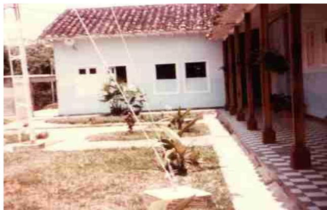
Fotografía – Antiguo hospital (Sala de hospitalización)
