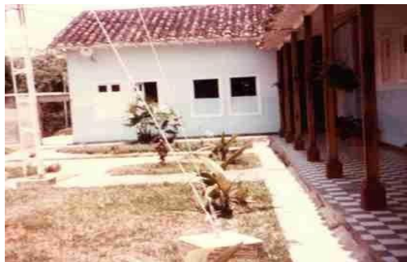
Fotografía – Antiguo hospital (Sala de hospitalización)
